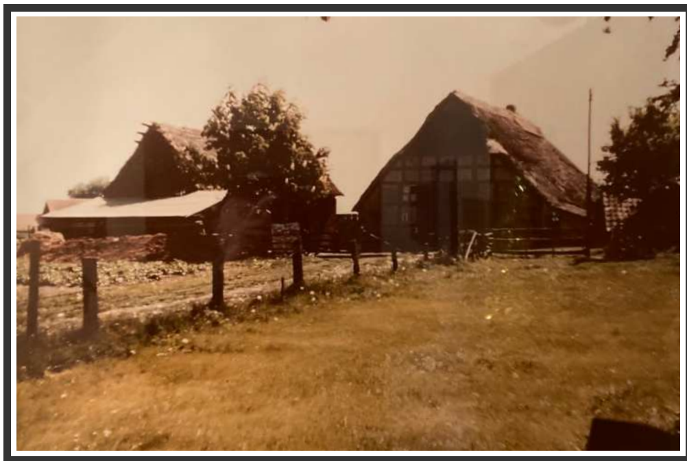
Abb. 6: Hofstelle Nr.10 um das Jahr 1960. Abriss des Gebäudes etwa 1961. Quelle: Brigitte Meyer
